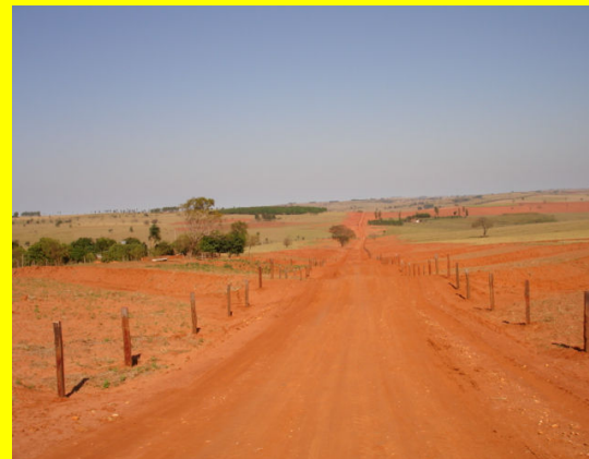
Trecho onde houve elevação do greide e implantação de sistema de drenagens (Depois)
