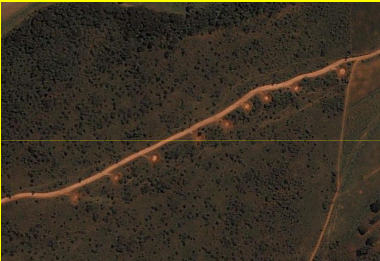
Bacias de captação de água em estrada não pavimentada em Rosário, MG (data 25/02/2003)
