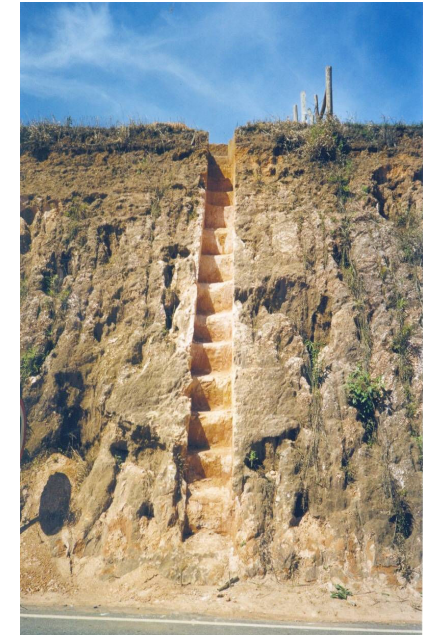
Dissipador de energia cinética.
