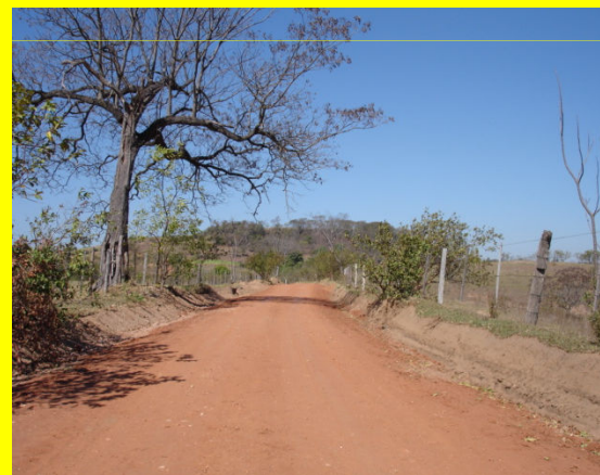
Adequação e sem abatimento de taludes (Depois)
